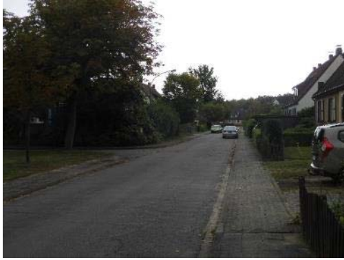
Straßenbeleuchtung in Marinesiedlung
