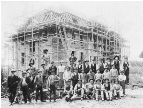
Schloss Eldingen in der Bauphase, ca. 1907. (Foto von Frau Gottschalk, Eldingen)
