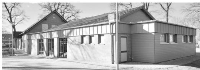
Dorfgemeinschaftshaus, Schulstraße 4, 29355 Beedenbostel
