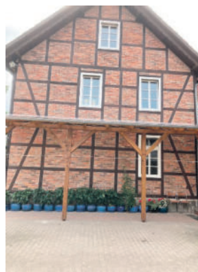
Hof Marwede in Beedenbostel (vor und nach der Sanierung)
