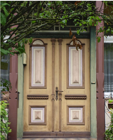
Abb. 6 Gut erhaltene Eingangstür aus Holz
