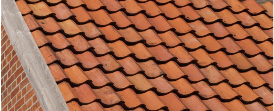
Abb. 2 Dacheindeckung mit Hohlfalzziegeln
