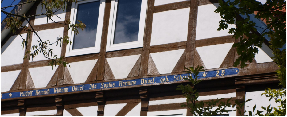
Abb. 8 mit Lehm verputztes Fachwerk
