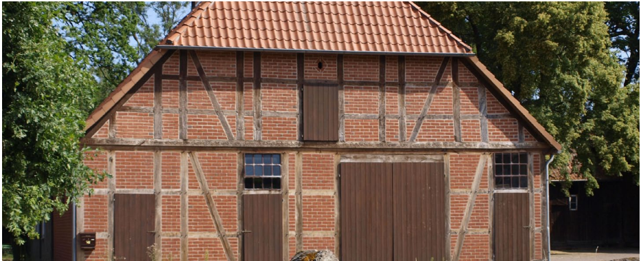
Abb. 9 ausgemauertes Fachwerk
