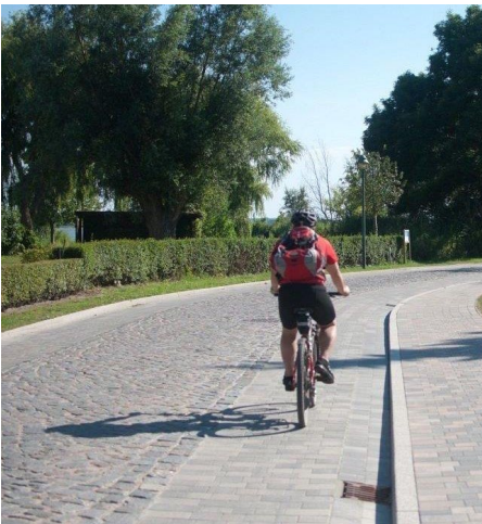
Abb. 11 Natursteinpflaster in Kombination mit Betonsteinpflaster
