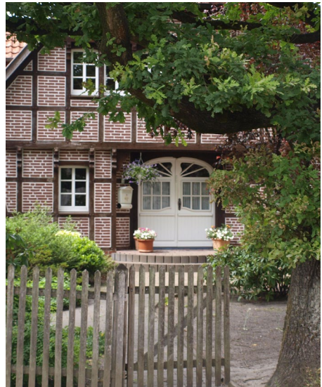
Abb. 7 Dorftypisch gestalteter Eingangsbereich mit Holzzaun und doppelflügiger Eingangstür
