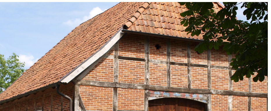
Abb. 4 Fachwerkgebäude mit Krüppelwalmdach
