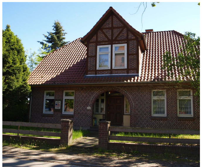
Abb. 7 Dach mit Giebelgaube
