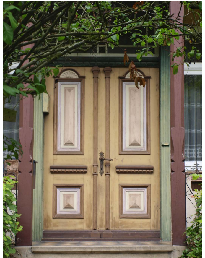
Abb. 17 Gut erhaltene Eingangstür aus Holz
