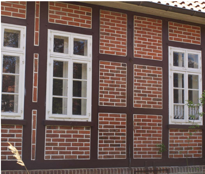
Abb. 15 Doppelte Holzfenster mit Kämpfer
