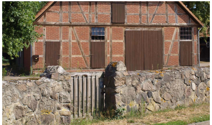
Abb. 22 Einfriedung mit Natursteinmauer und Holzpforte
