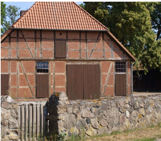
Abb. 9 ausgemauertes Fachwerk
