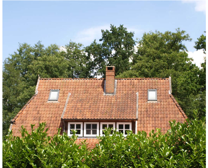
Abb. 5 Dach mit Schleppgaube
