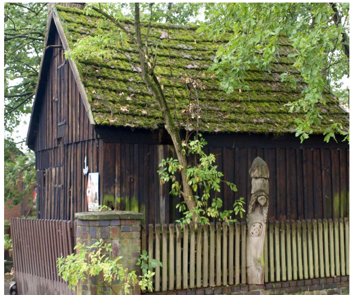
Abb. 13 Nebengebäude mit typischer Boden-Deckelschalung aus Holz
