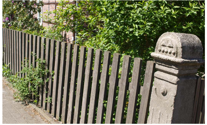
Abb. 21 Staketenzaun mit Steinsockeln
