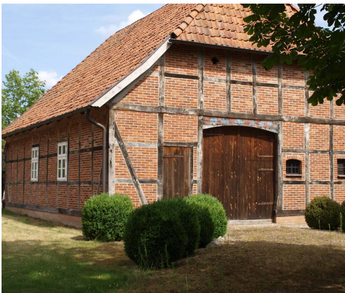
Abb. 4 Fachwerkgebäude mit Krüppelwalmdach
