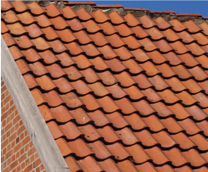
Abb. 2 Dacheindeckung mit Hohlfalzziegeln
