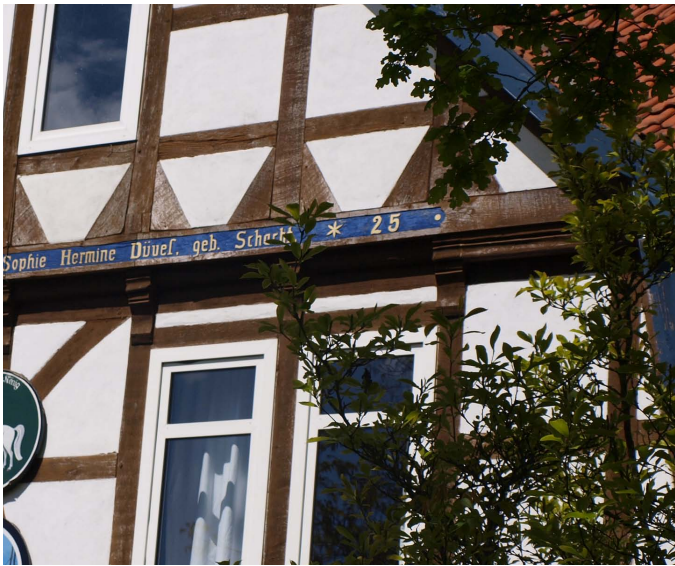
Abb. 8 mit Lehm verputztes Fachwerk
