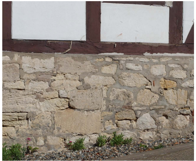
Abb. 11 Natursteinmauerwerk als Sockel unter dem Fachwerk
