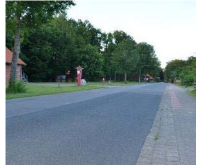
Straße „Im Lachtetal“ (K 80)
