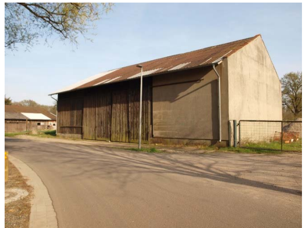
Feldscheune im Nordosten des Plangebietes, zum Abbruch bestimmt (Mitte April 2018)
