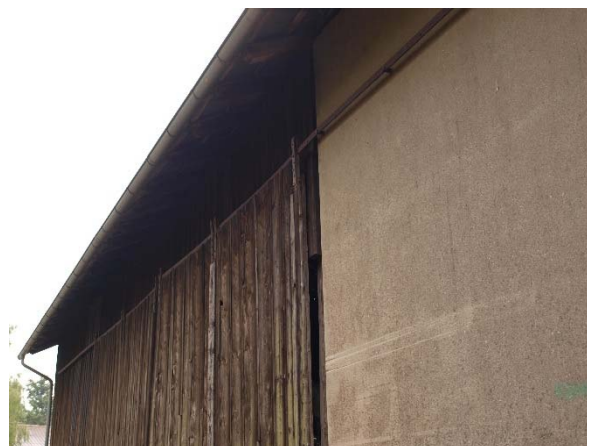
Traufen der Feldscheune ohne Gebäudebrüter (Mitte Mai 2018)
