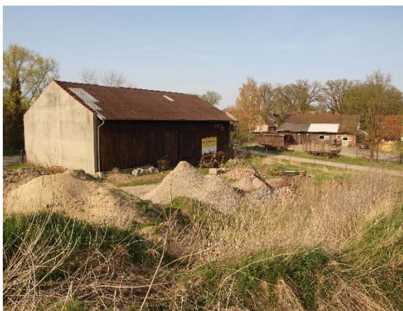
Lagerplatz mit einjähriger Ruderalflur und Feldscheune von Südwesten betrachtet (Mitte April 2018)
