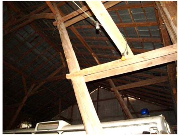
Gebäudekontrolle im Inneren der Feldscheune – Balkenkonstruktionen, ohne Befunde (Mitte Mai 2018)
