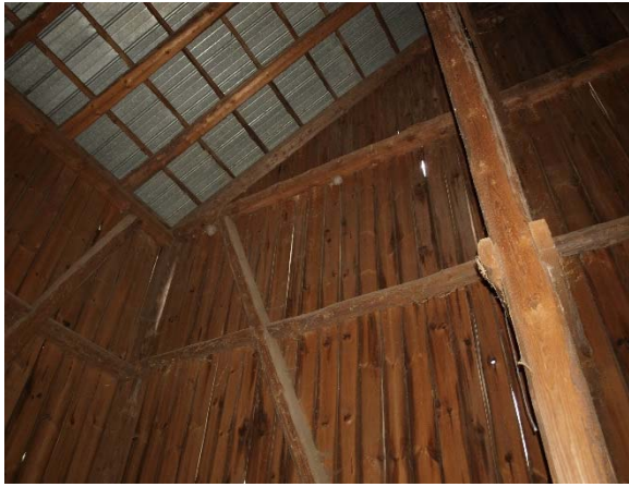
Gebäudekontrolle im Inneren der Feldscheune – einfache Wandungen, ohne Befunde (Mitte Mai 2018)
